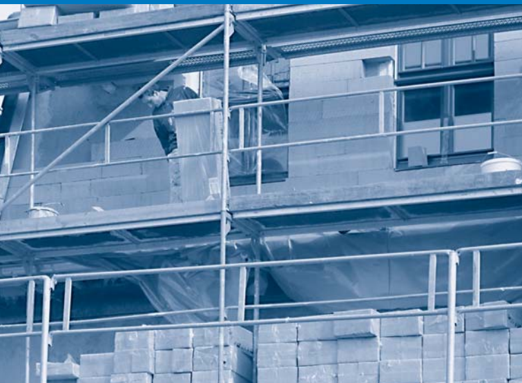
Foto: Bildungszentrum der Handwerkskammer Münster, Gelsenkirchen, Deutschland
